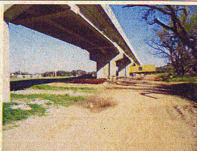
Figura 6. Imagens da manutenção em finalização.
