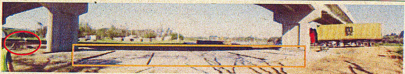
Figura 12. Imagens de um dos locais onde estão sendo realizadas atividades para as obras de duplicação.
