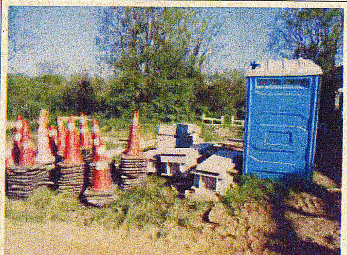
Figura 4. Materiais já retirados da rodovia.
