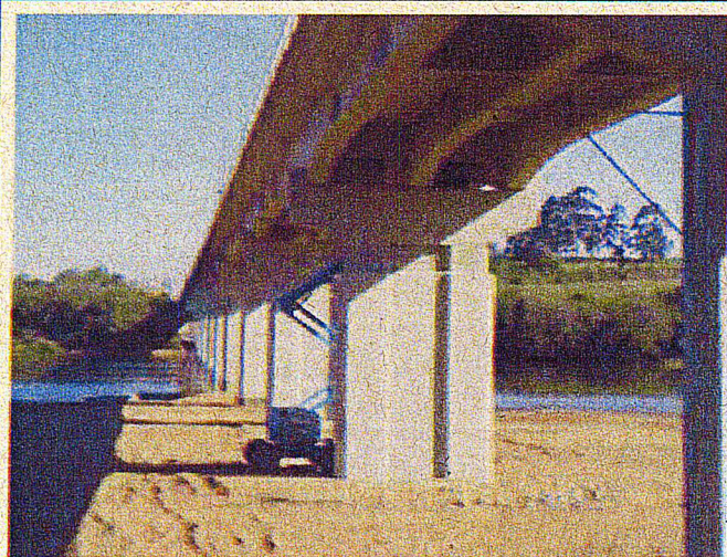
Figura 5. Imagens da manutenção em finalização.
